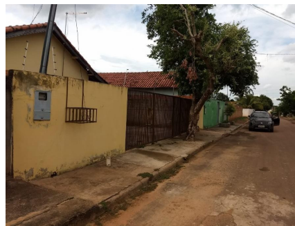
Representação Vista da Rua Descrição Lat. Direita da edificação Data Foto 10/01/2020
