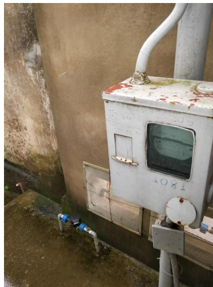
Representação Fachada Descrição Luz Data Foto 10/11/2018
