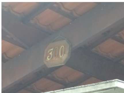
Representação Fachada Descrição Data Foto
