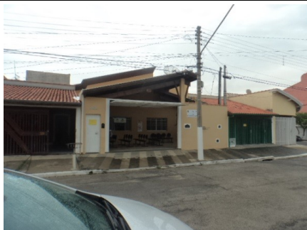
Representação Fachada Descrição Data Foto
