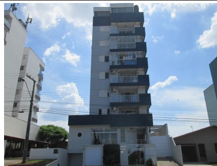
Representação Fachada Descrição Data Foto 27/12/2019
