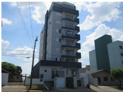
Representação Fachada Descrição Data Foto 27/12/2019
