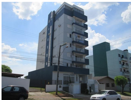
Representação Fachada Descrição Data Foto 27/12/2019
