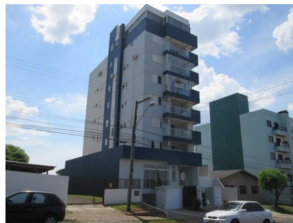
Representação Fachada Descrição Data Foto 27/12/2019
