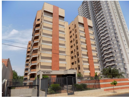
Representação Fachada Descrição Data Foto 13/10/2018
